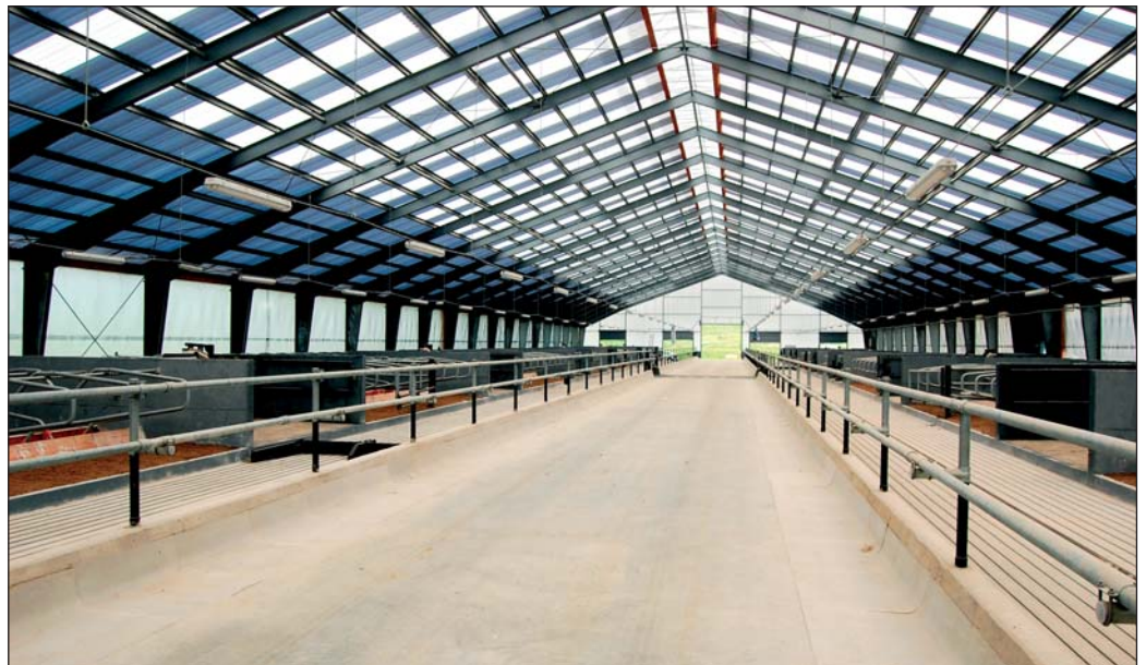
Celkový pohľad na kŕmnu chodbu novej maštale pre 720 dojníc.
