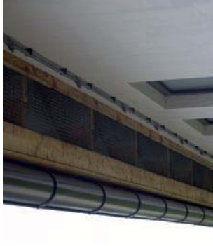
Wolf System: Traufenzuluft
