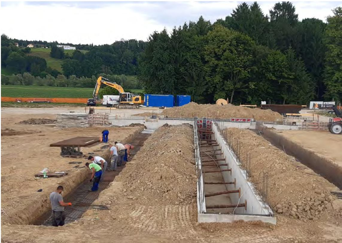
Abbildung 44: Erstellen der Zuluftkanäle (Bildquelle: Fa. Lorber und Partner)
