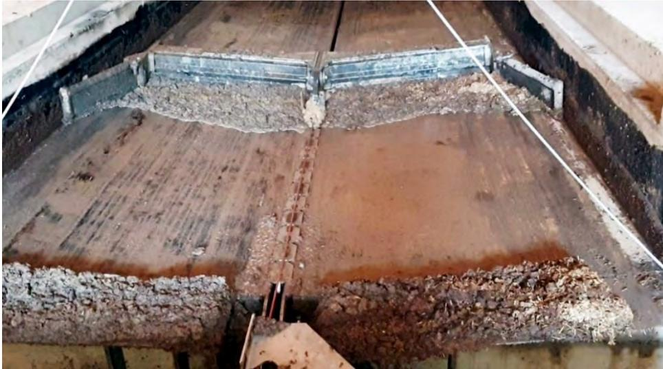
Abbildung 40: Schieberkanal mit Beschichtung und mittig vor dem Kotschieber abgedeckter Urinrinne
