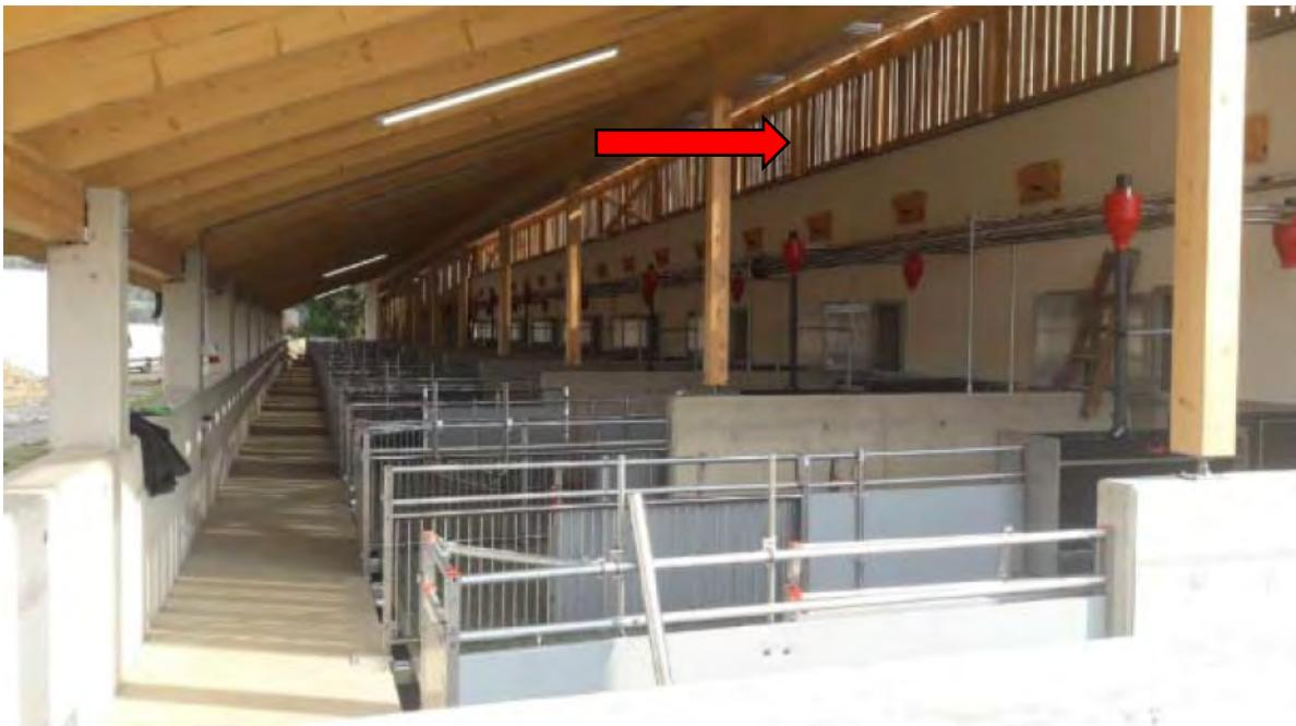
Abbildung 90: Außenbereich mit Lüftungsöffnungen im Firstbereich
