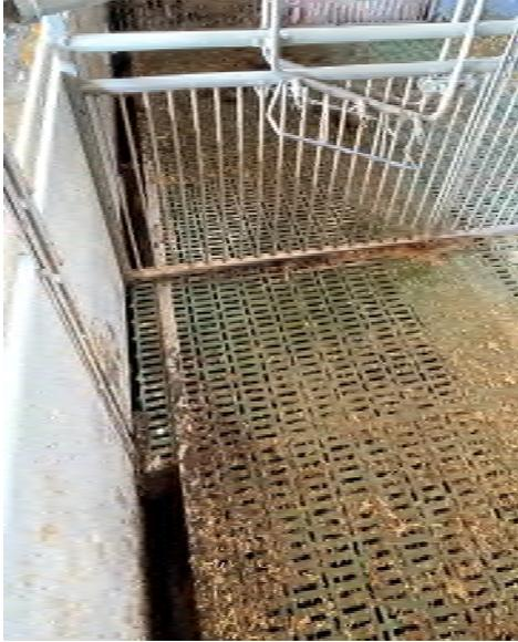
*Abbildung 83: Permanenter Verschluss des Kotschlitzes durch 75 cm langes Kunststoffrost-Element im Tränkebereich*
