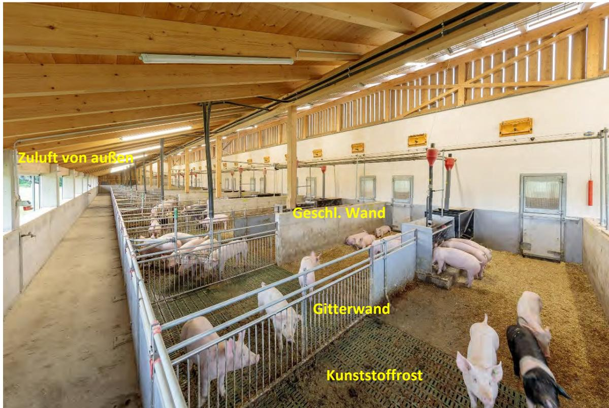
Abbildung 39: Kotbereich im Außenklima (Bildquelle: Neuhold, Steirischer Tierschutzpreis)
