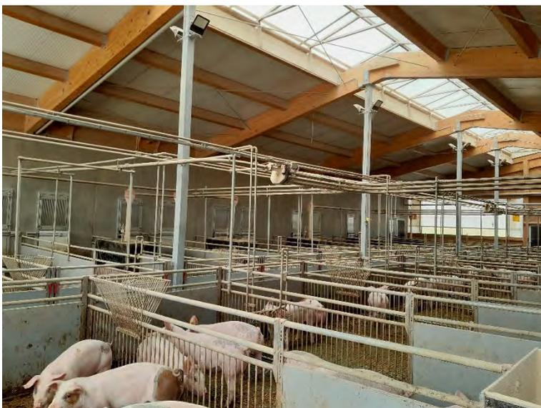
Abbildung 185: Aktivitätsbereich als Innenhof mit groß dimensioniertem Lichtfirst und geöffneten Stirnseiten
