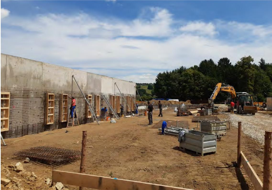
Abbildung 45: Schalungsarbeiten für die Wand in den Auslauf (Bildquelle: Fa. Lorber und Partner)
