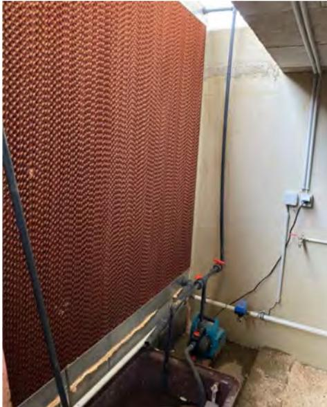
Abbildung 91: Cool Pads zur Zuluftkühlung
