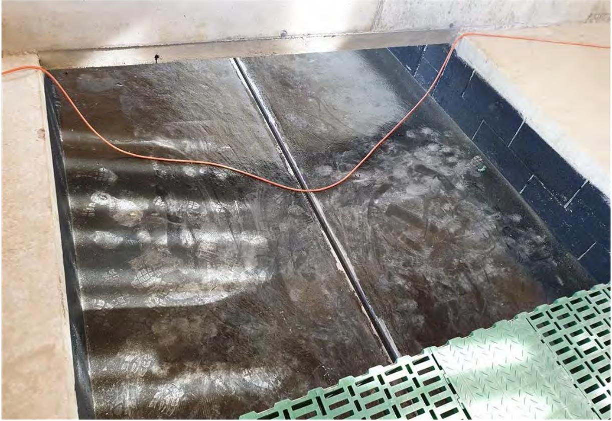
Abbildung 53: Entmistungskanal mit Beschichtung (Bildquelle: Fa. Lorber und Partner)
