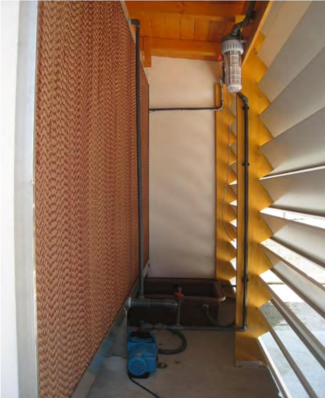
Abbildung 33: Cool Pad-System (links) mit Lamellenwand (rechts), Pumpe und Auffangwanne
