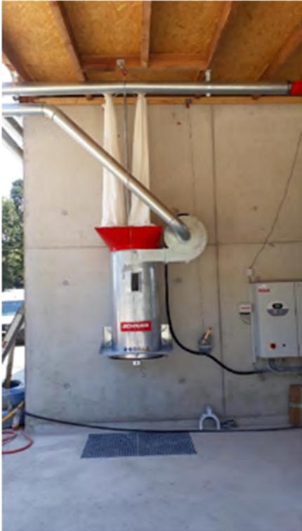
Abbildung 166: Absauganlage (Fa. Schauer)
