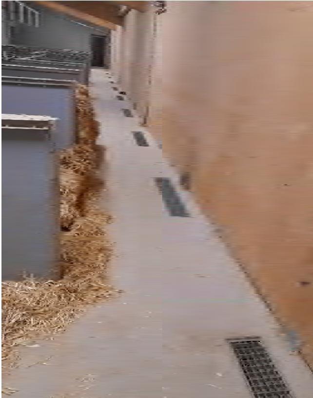
*Abbildung 181: Zuluft einbringung in den Ruhebereich über eine Unterflurzuluft mit Cool Pads*
