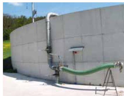
Gülleentnahme mit Schlauchanschluss
