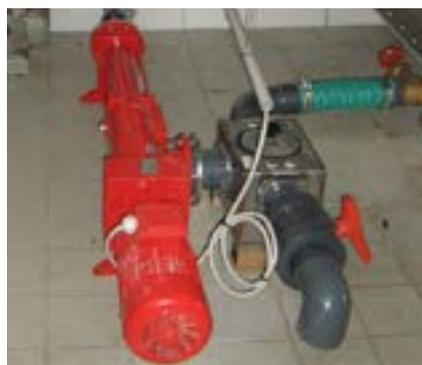
Um Schäden an den Pumpen zu vermeiden kann optional ein Fremdkörperabscheider zum Einsatz kommen. Dieser kann auch mit Magnetpatronen ausgerüstet werden.
