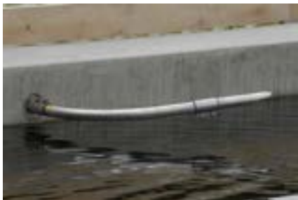
Werkzeuglos abnehmbarer Futterauswurf am Maueranschluss
